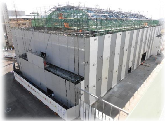
体育館棟の屋根の骨組みが見えてきました！
