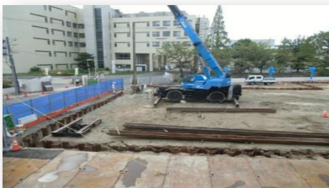
矢板を打ち込んでいるところです。
